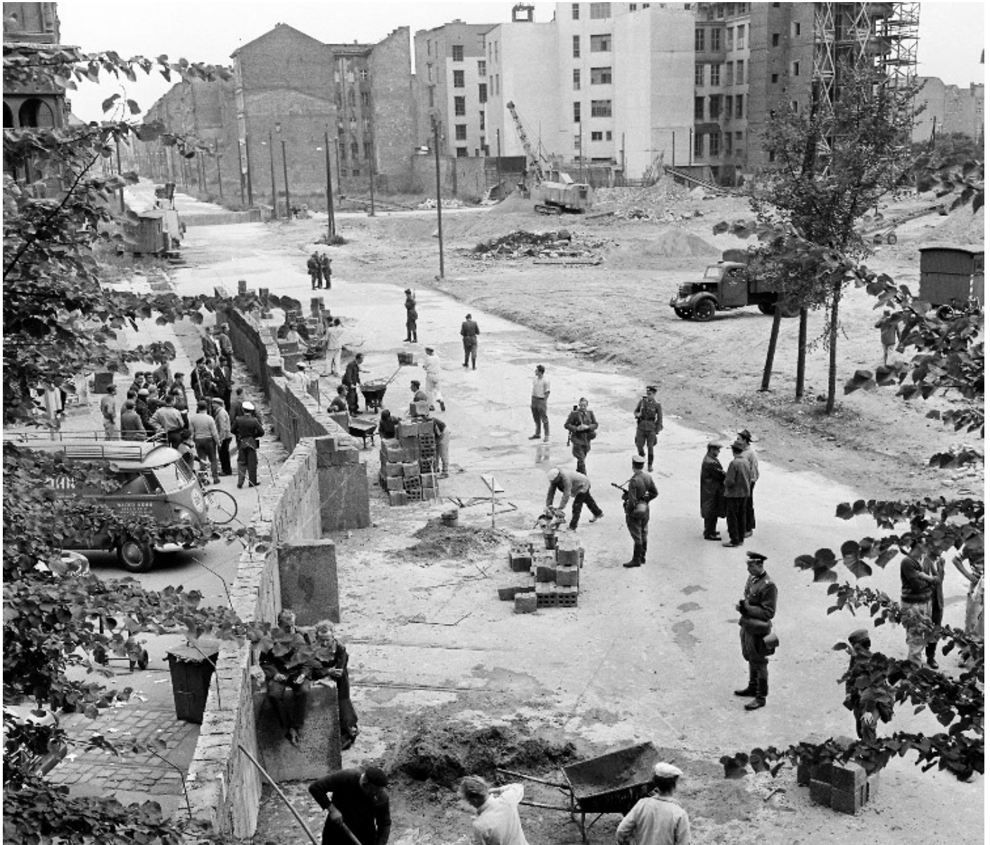
M2: Errichtung der Mauer zwischen Berlin-Treptow und Berlin-Neukölln an der Harzer Straße (Aufnahme: etwa 18. August 1961) Quelle: Presse- und Informationsamt der Bundesregierung
